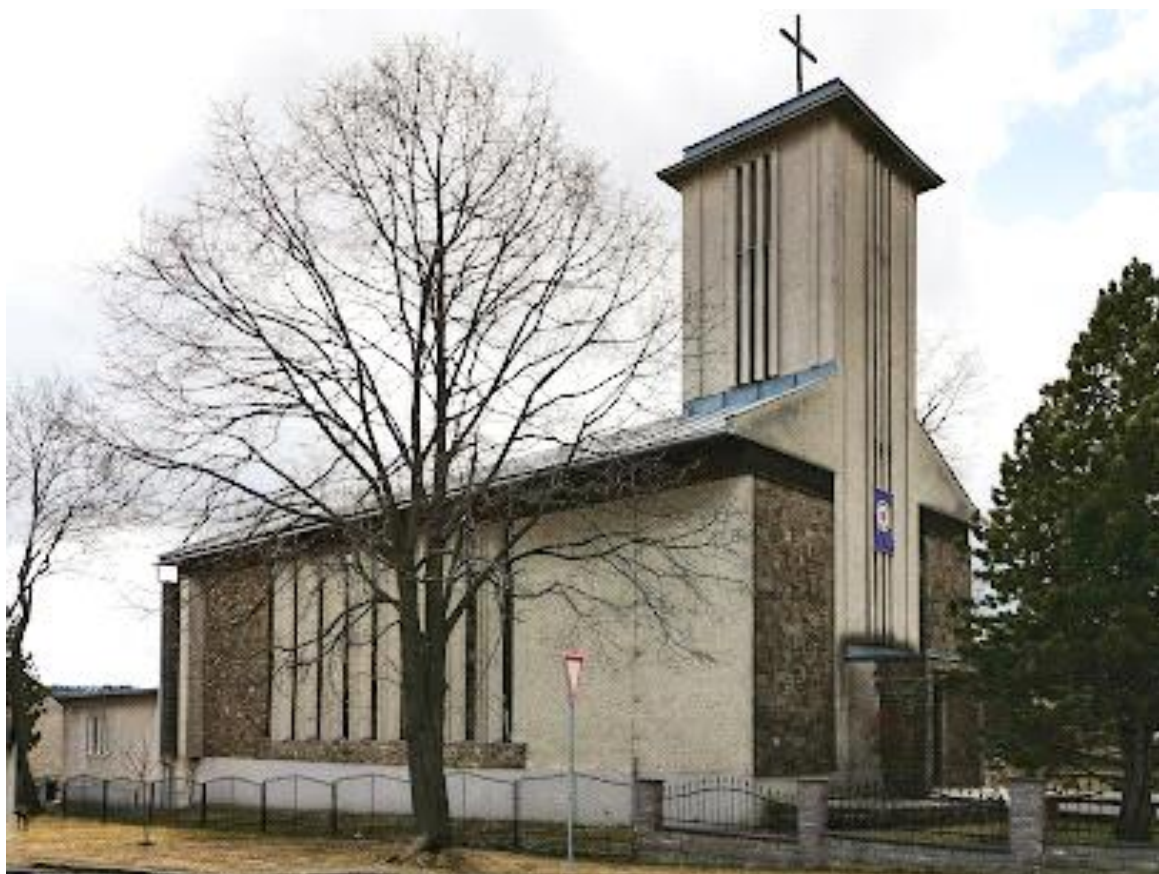
Ev.a.v. kostol, Švábovce
