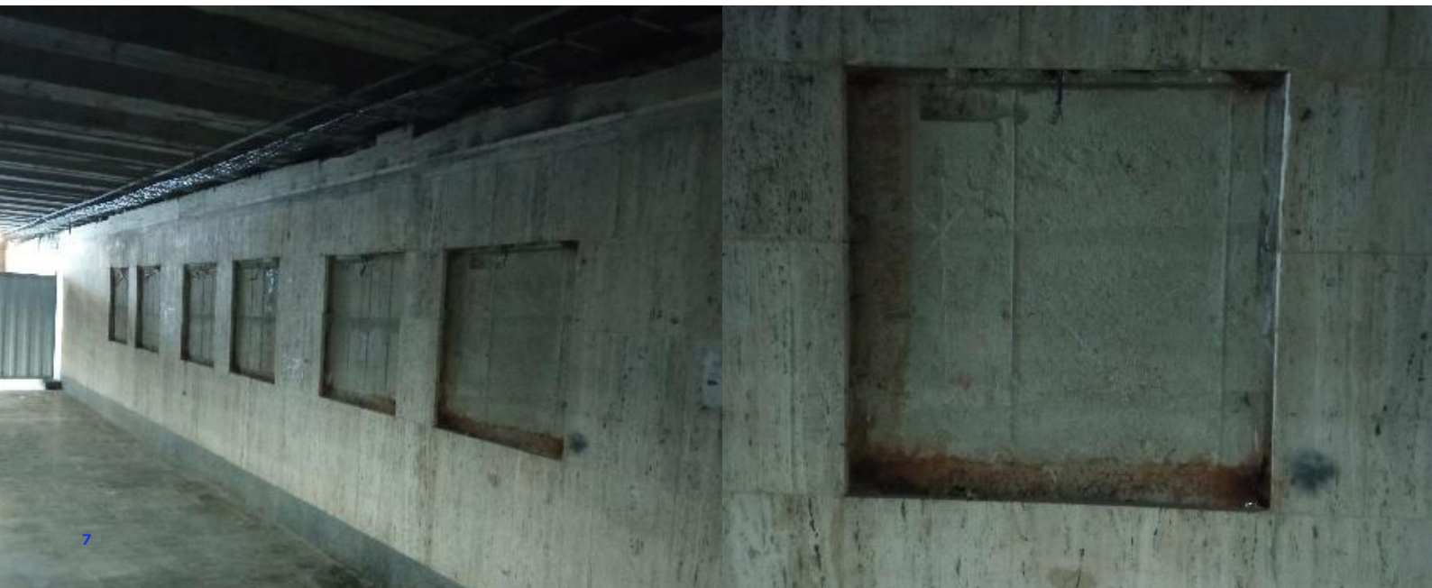
Obr. 9 - 10: Detail ník v pôvodnom stave
